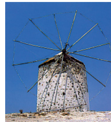
古老的地中海风车，有着原形石塔和朝向盛行风安装的垂直翼板。它利用风能磨碎谷物。
