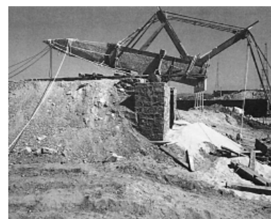
一个由多国考古学家与工程师组成的实验小组，在花岗岩采石场，尝试以拉绳方式竖立方尖碑。
